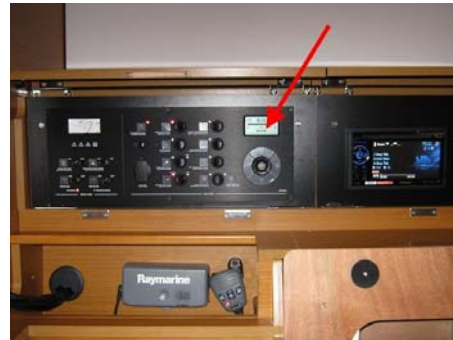
Füllstandsmesser (auf der Schalttafel)
