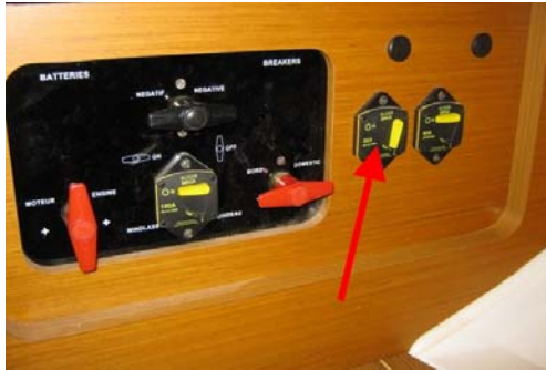
Schutzschalter (30A) Standort - BB-seitige Achterkabine
