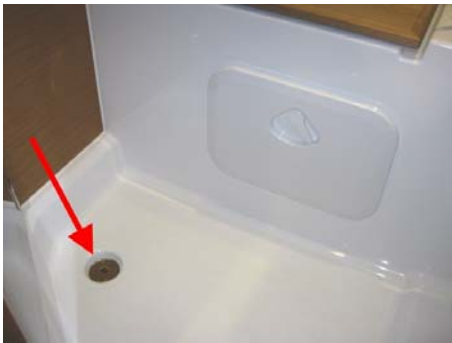
Bedienswitcher der Abflusspumpe
