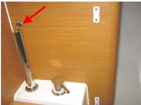
Bedienswitcher der Abflusspumpe
